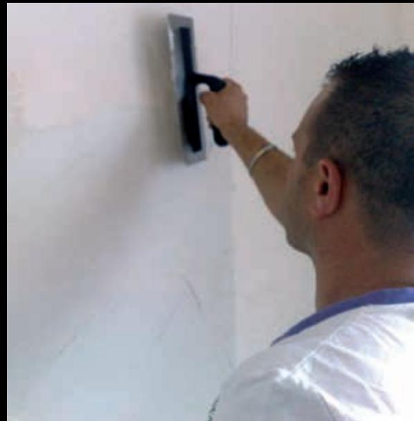
Stendere la colla all'interno del perimetro tracciato con una spatola dentata da 3 millimetri facendo attenzione a non lasciare grumi. / spread out the adhesive inside the perimeter using a 3 mm toothed spatula and taking care not to leave any lumps.
