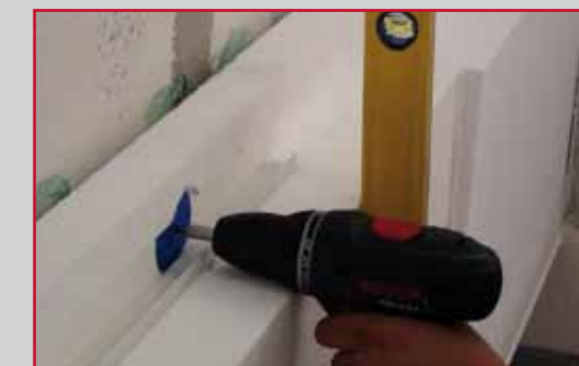
Die Dämmplatte wird mittels Akkuschrauber und Wasserwaage in den gewünschten Abstand zum Untergrund hin eingestellt
