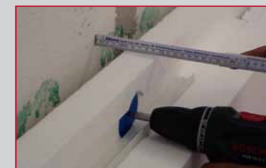
Je nach eingesetztem Dübel beträgt der mögliche Einstellbereich für Unebenheiten maximal 25 mm oder maximal 45 mm
