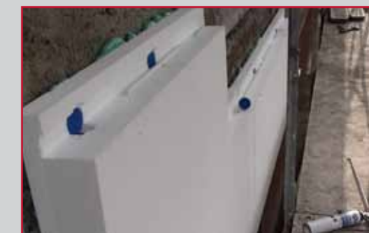
Durch die vorherige Befestigung kann der Schaum ungehindert expandieren, die Dämmplatten können dabei ihre Position nicht mehr verändern
