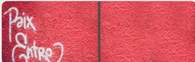
Einsatz bei der Beseitigung von lästigen Graffiti
